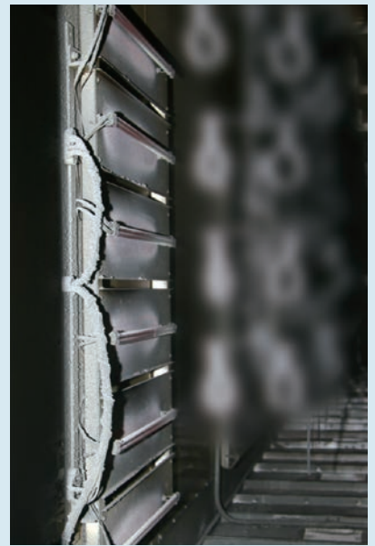
▲ 1箇所につき6本のヒーターを設置
